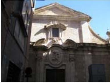
Las **aletas** y **volutas**, elementos en forma de cinta curva que podían acabar en su extremidad enrollándose sobre sí misma, y que unía armoniosamente dos partes del edificio que se encontraban a distinta altura, son característicos de este periodo. Decoran frecuentemente las fachadas de las iglesias, su uso es tan decorativo como constructivo (eran un elemento que ayudaba a contrarrestar el peso ejercido por las bóvedas).
